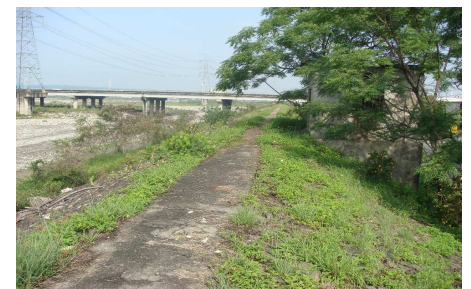
北岸路旁堤防
